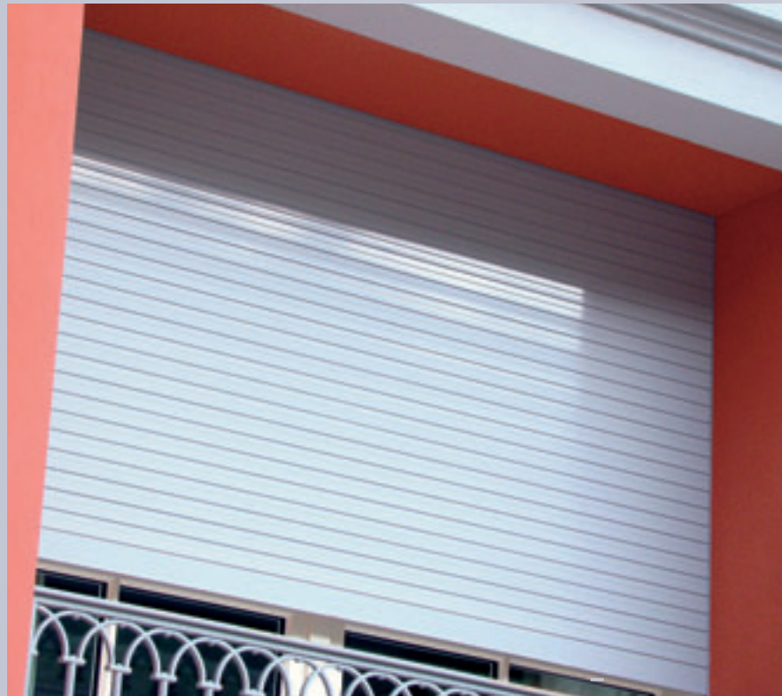
Die Rolladenstäbe sind standardmässig ohne Luft- und Lichtschlitze.
